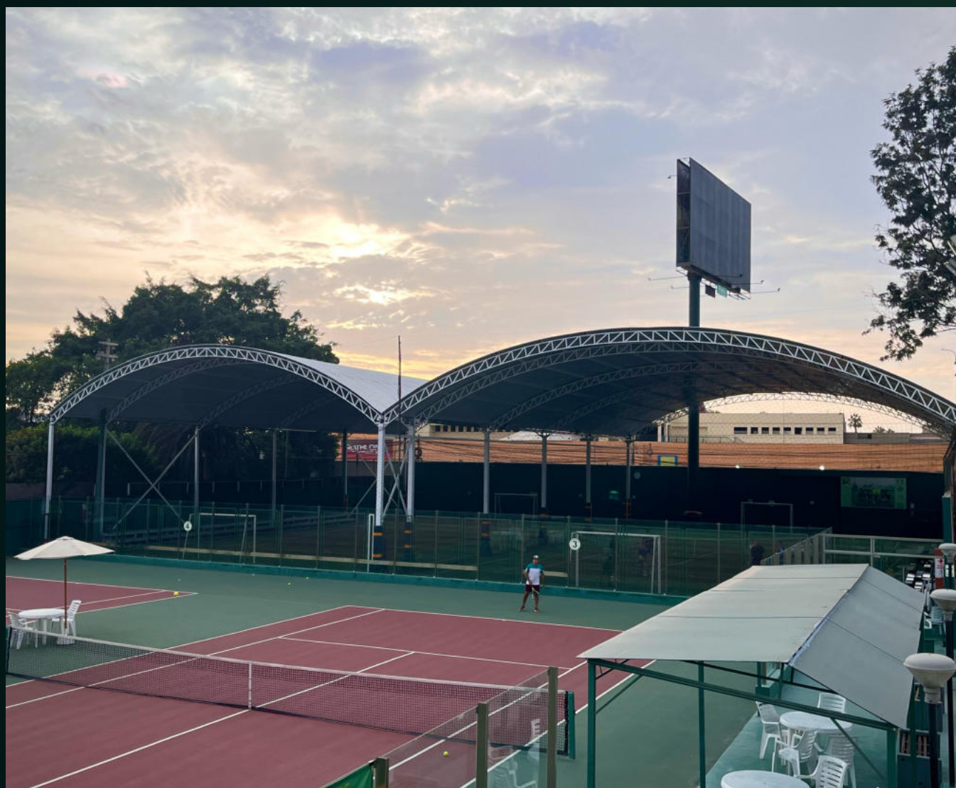
Construcción de Techo Parabólico para canchas de fútbol
