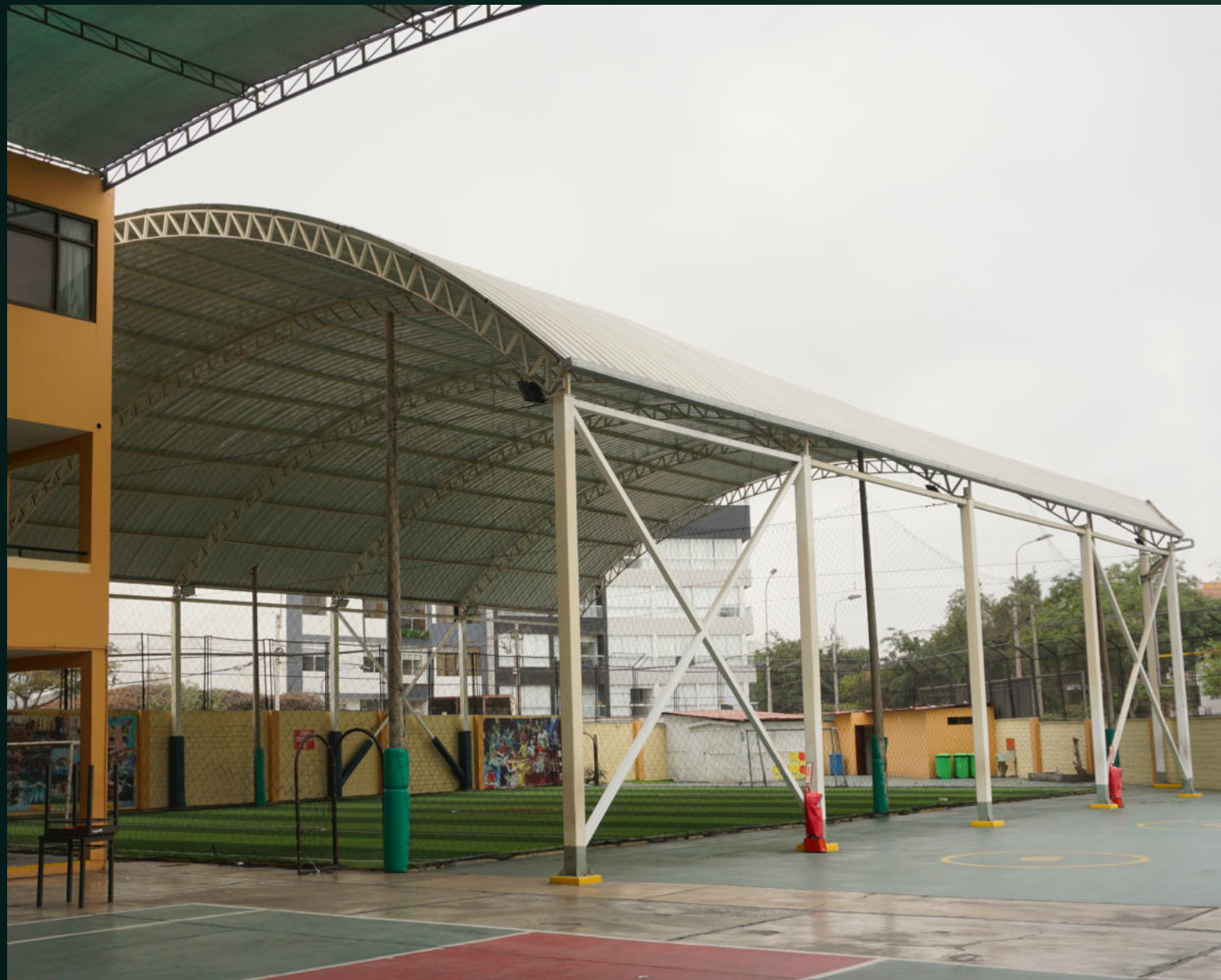
Construcción de Techo Parabólico para cancha de fútbol
