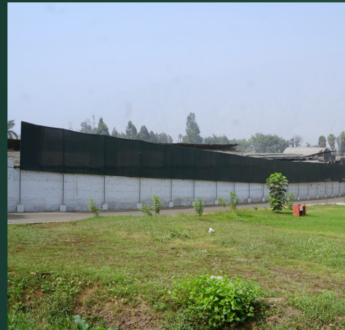
Extinción de moscas y aislamiento de granja
