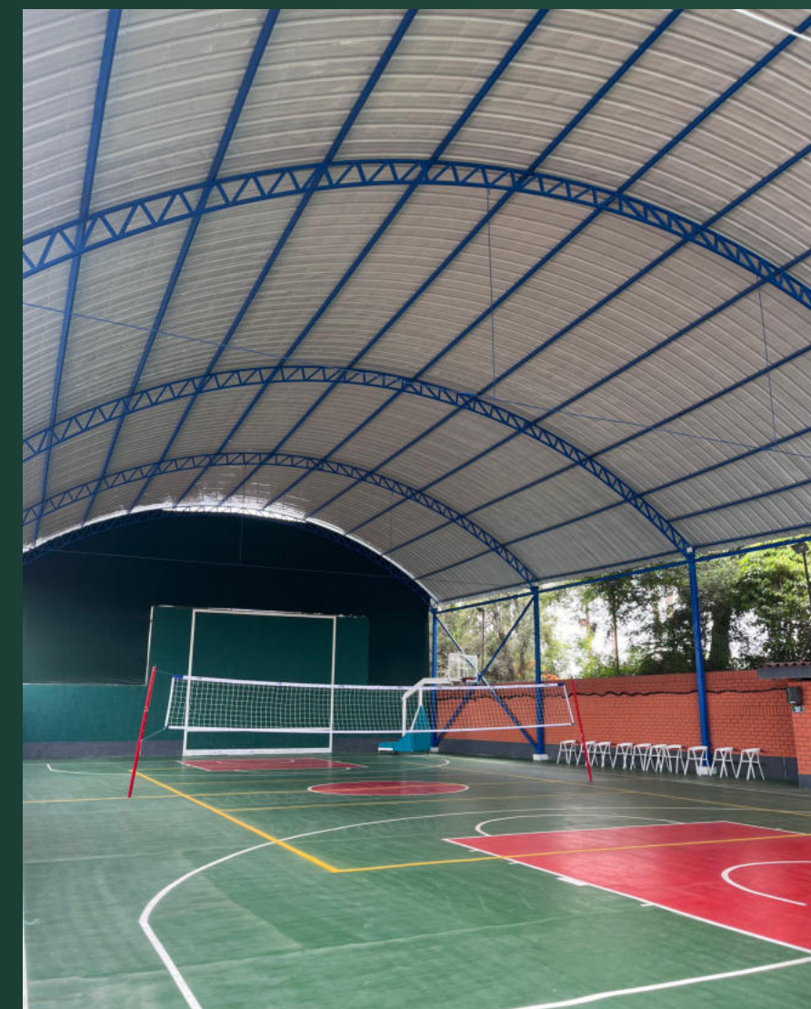
Construcción de Techo Parabólico para cancha múltiple
